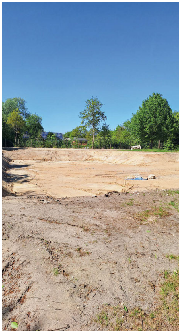
Bislang kündigt in Högel nur eine Baugrube vom neuen Schwimmbad.
