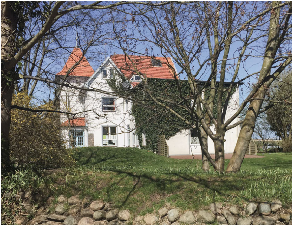
Das Haus des Gastes in Nebel auf Amrum soll abgerissen werden.
