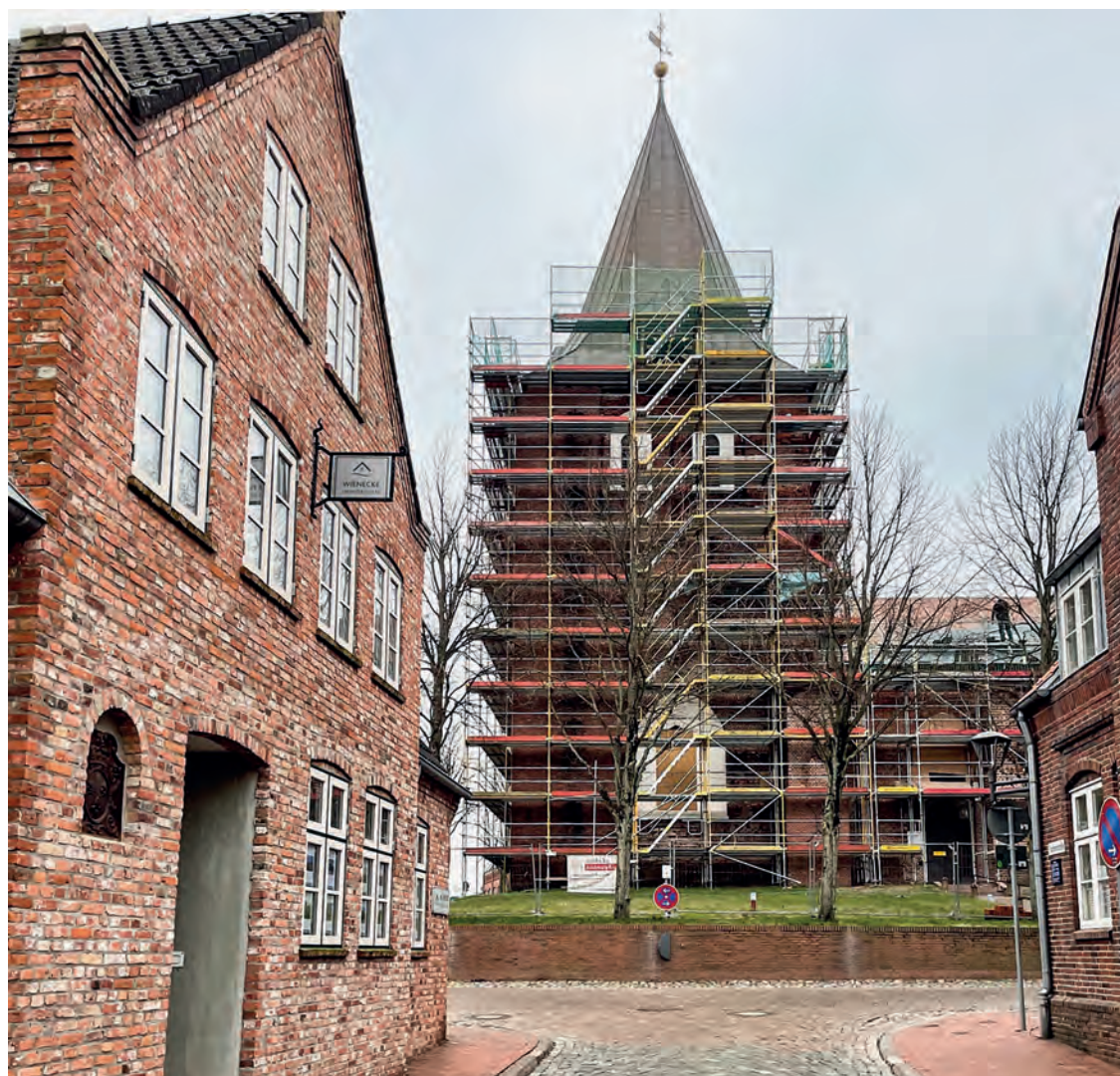
St. Christians in Garding voll eingerüstet bekommt ein neues Schieferdach
