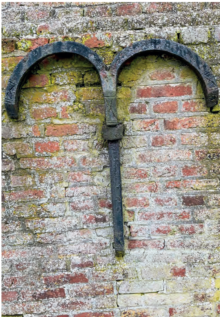
Mehr als Zierrat: Maueranker halten auf dem weichen Marschgrund Türme und Kirchenschiffe zusammen
