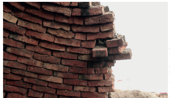
Abb. 8: Einlauföffnung an der Innenseite des Ziegelsods, erkennbar durch den überstehenden Ziegelstein
