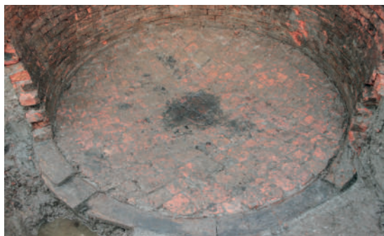
Abb. 9: Die Sohle des Sods war sorgfältig mit Ziegelbruchstücken gepflastert. In der Mitte sammelt sich der letzte Rest des gespeicherten Wassers.
