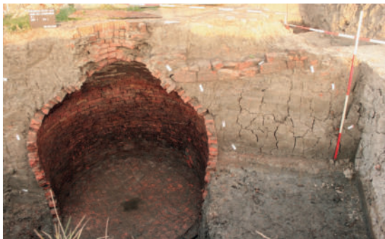
Abb. 7: Der aufgeschnittene Ziegelsod von innen. Rechts oben die unterirdisch verlaufende, abgedeckte Zulauf- rinne aus Ziegeln
